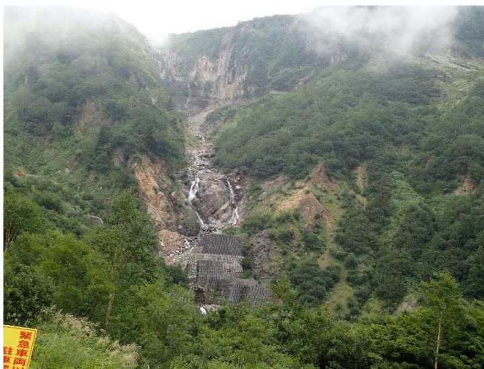
図 21 甚之助谷砂防堰堤群
